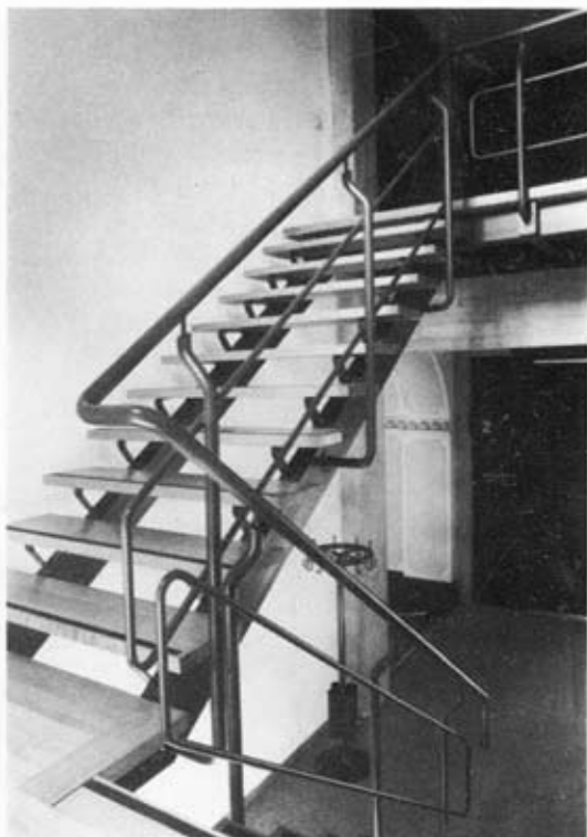
Fig. 7 - Le nouvel escalier donnant accès à la salle d'audience dans les com- bles.
