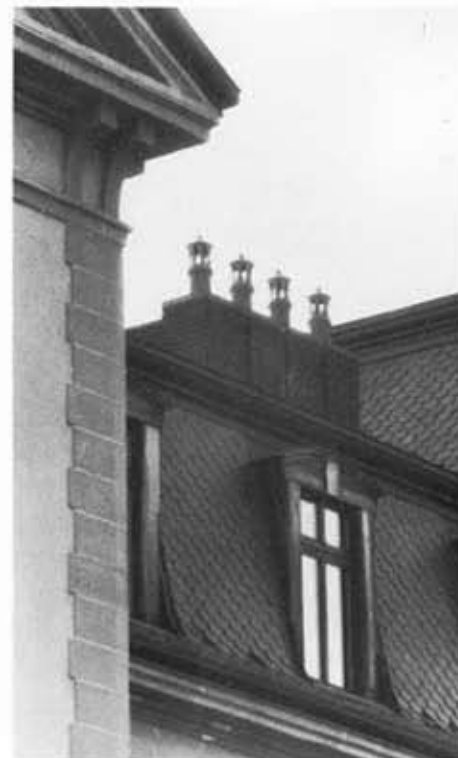
Fig. 6 - Les cheminées masquant la présence de la cage d'ascenseur.
