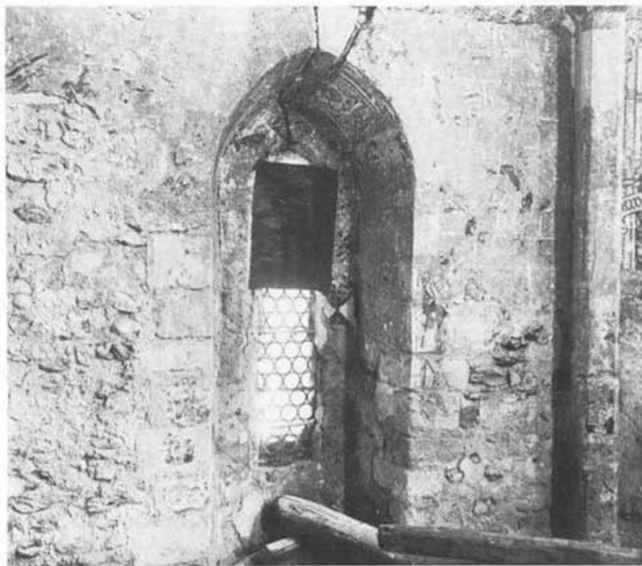
Fig. 1: Peintures murales du chœur. Exemple d'une partie fortement dégradée du registre intermédiaire, côté nord. Sur l'intonaco (enduit fin) largement conservé du XIII e s. avec ses traces importantes de dégradation dues partiellement aux travaux de dégagement par Christian Schmidt, sont visibles des parties notables du décor d'origine sous forme d'une peinture en quadrillage; par-dessus, de faibles traces de la peinture du XV e s. Etat en 1898, avant la restauration.
