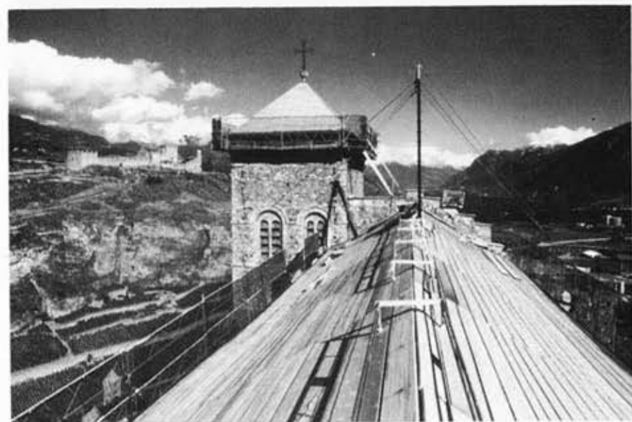
Toitures en réfection.
