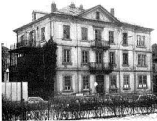
1979 Maison Evêquois, alias de Torrenté 1864, Charles Auver- gne (Genève) architecte Vers 1900 et 1920, agrandissements Rue de Lausanne 35 (photo J.-M. Biner)
