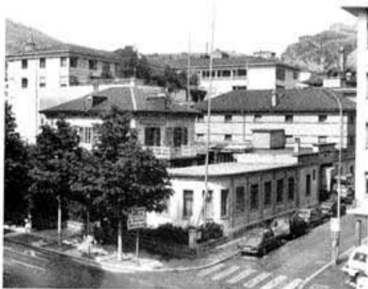
1986 Villa Bonvin 1880-1900, entourée de bâtiments d'explo- itation par la suite Avenue de la Gare 36 (photo R. Hofer)
