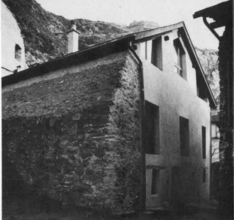
Vue de la façade sud et du rempart avant intervention.
