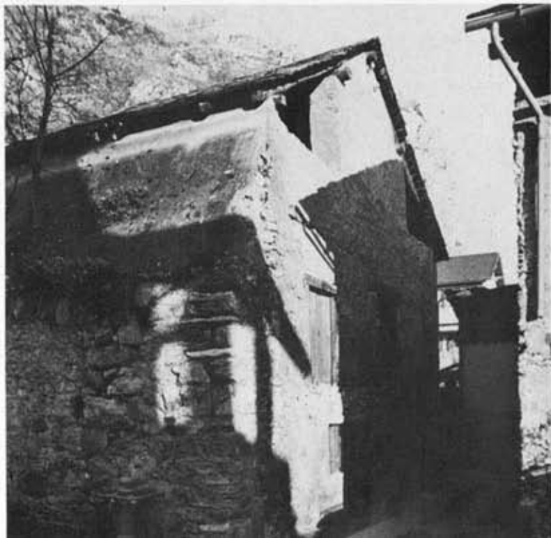
Après intervention : l'on constate que seule une nouvelle fenêtre a été percée.
