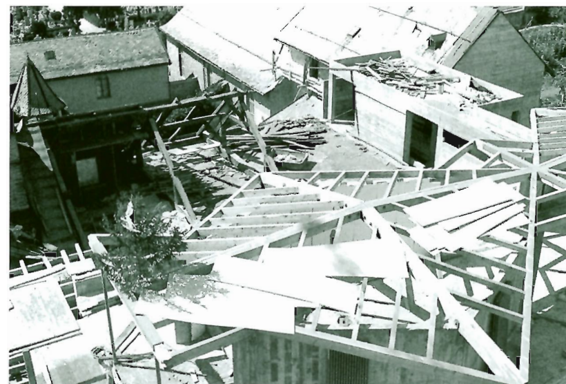
Bouquet sur la charpente de l'aile est vers 1966
