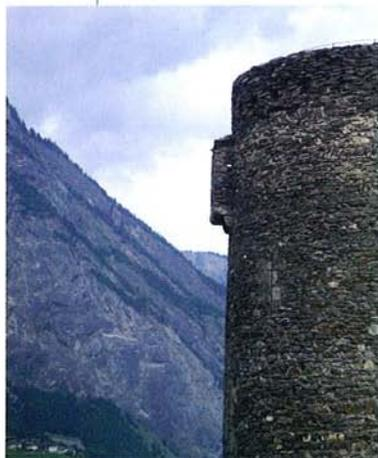
**III. 33** Les latrines de la tour de Saillon. Ici l'encorbellement maçonné est encore parfaitement conservé.
