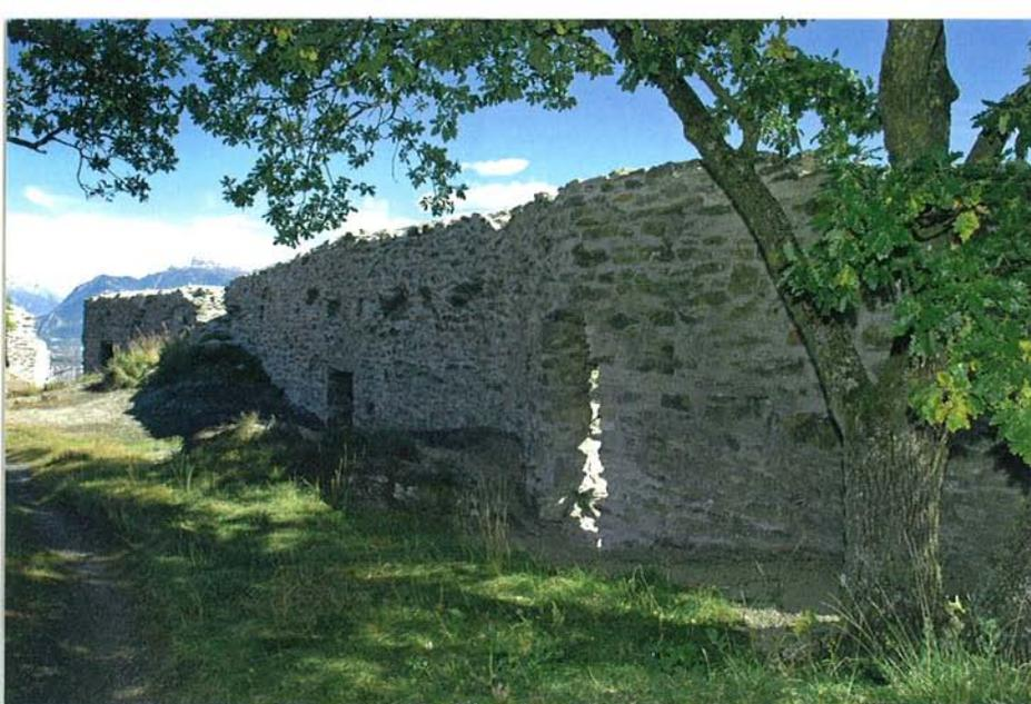
**III. 34** La face intérieure de la courtine sud. De part et d'autre des latrines, des logements d'un solivage indiquent l'existence de bâtiments adossés contre le mur d'enceinte.
